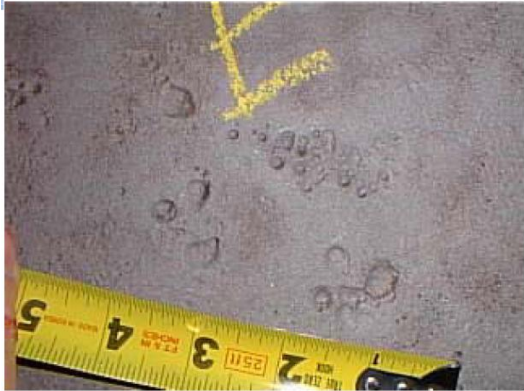
شکل E1 : خوردگی های مشاهده شده مربوط به مثال ۱
