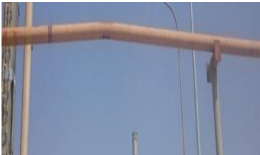
شکل ۳-۲۴: خمش در لوله های فرایندی
