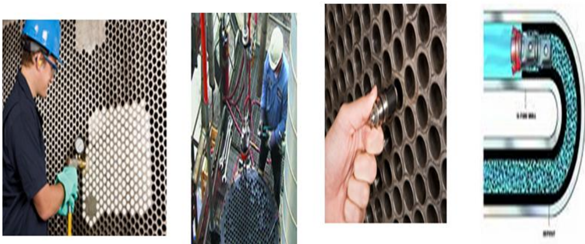
شکل ۳-۳۶: روش های تمیزکاری داخلی تیوب ها
