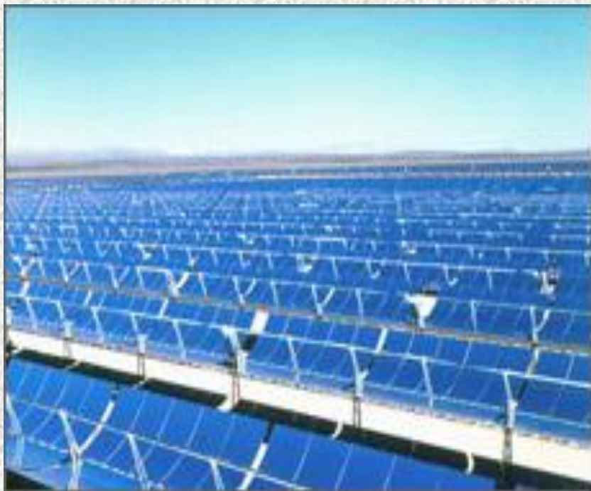
تصویر- نیروگاه خورشیدی SEGS III
