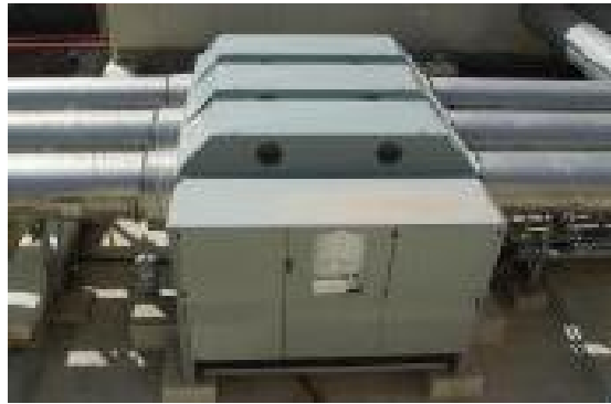
1,11. سیستم خنک کننده ژنراتور. Generator Cooling Sys. :
